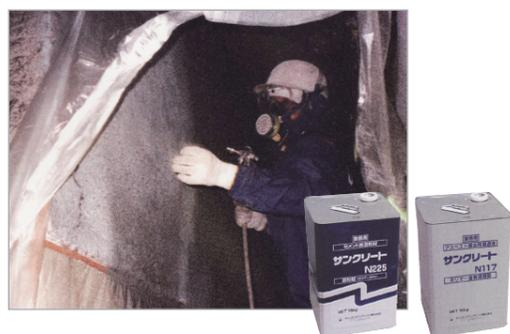
アスベスト粉じん飛散防止処理技術「ワイシステム工法」
